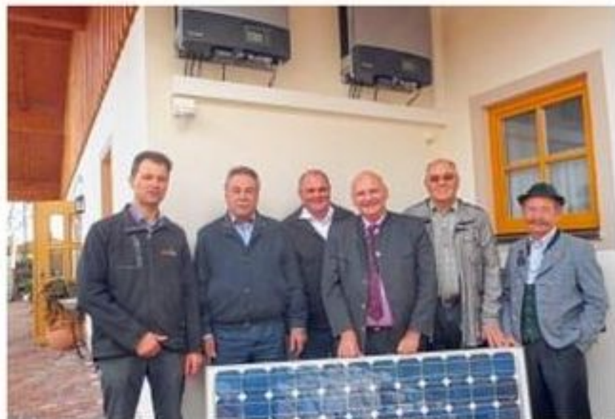
Im Display der Wechselrichter (oben) können Vereinsvorstände und Verantwortliche jederzeit ablesen, wie viel Strom erzeugt wird.
